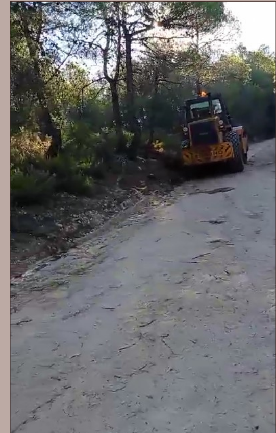
Tram C: Treballs de «rulo». Part més baixa del tram C.
