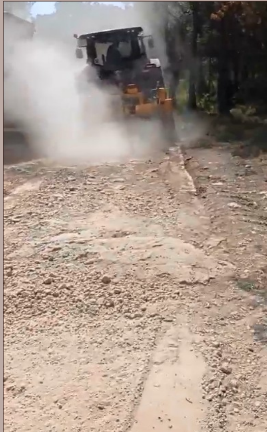
Tram A: Detall del material després de la primera passada de fresadora
