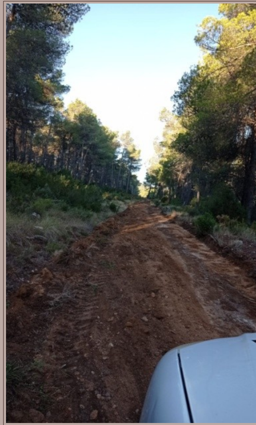
Tram B: Estat del camí després de l'ampliació de 40 cm en cada marge
